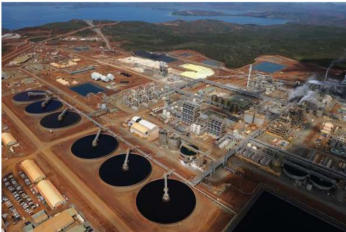
Le procédé consiste essentiellement à faire subir différents traitements au minéral réduit en pulpe par l'ajout d'eau, en utilisant une solution d'acide pour en extraire du nickel, transformé en oxyde de nickel et du cobalt, transformé en carbonate de cobalt.
